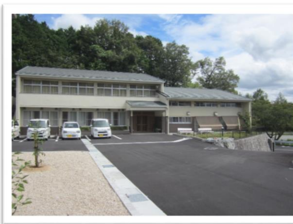
小規模多機能棟（小規模多機能ホームあかり）
